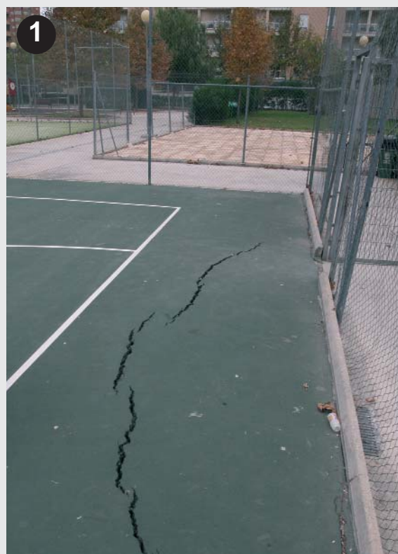
1. Una grieta de grandes dimensiones atraviesa el firme del campo exterior del polideportivo de Valterna. 2. Pavimento dañado durante una de las inspecciones a las instalaciones de Valterna, en la que se aprecia otra enorme grieta. 4. Pavimento que conduce a La Canyonada, para disminuir la velocidad de los coches. 5. Las filtraciones de agua en grandes cantidades han ocasionado un gran deterioro a los sótanos, donde está la maquinaria. 6. Las lluvias provocaron el desbordamiento del alcantarillado.
